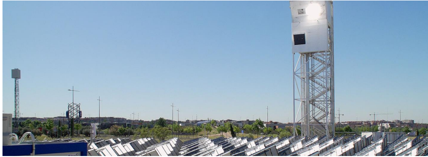
Solaranlage SUN-to-LIQUID zur Herstellung von Kerosin
